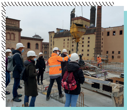
Découverte du chantier du nouveau quartier Fischer à Schiltigheim avec Eiffage et 25 conseillers et professionnels de l'emploi
